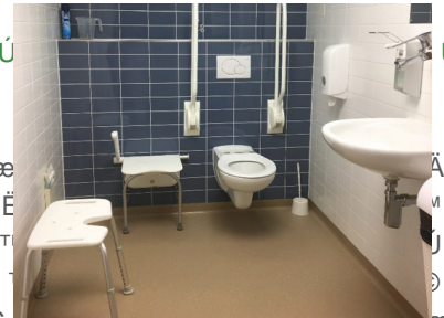
Na de verbouwing
